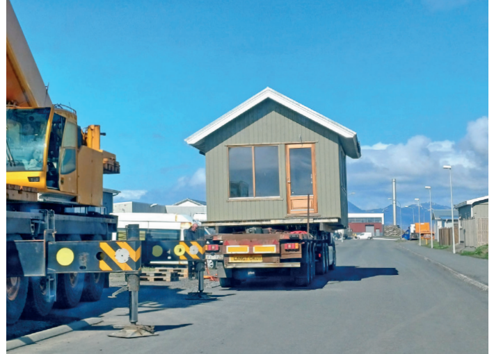
Sífelldar endurbætur eiga sér stað á orlofshúsunum og hér er verið að flytja nýtt gestahús að Ásenda 9 í Húsafelli árið 2024.
